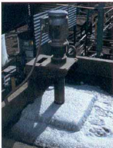
Fig. 7 Aeratorul instalației Hydro – Cal CAF
